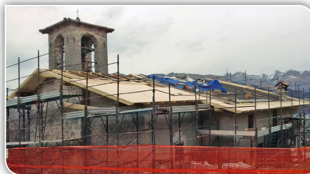
Visione dei restauri in corso alla chiesetta di Barbata.
