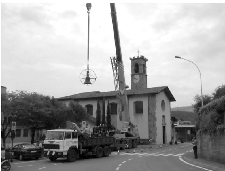
2001 - La fase di ricollocazione delle campane, dopo gli interventi di manutenzione resisi necessari dopo quasi 50 anni di incessante “lavoro”.
